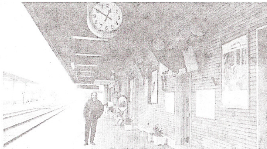
La stazione ferroviaria di Forte-Querceta
